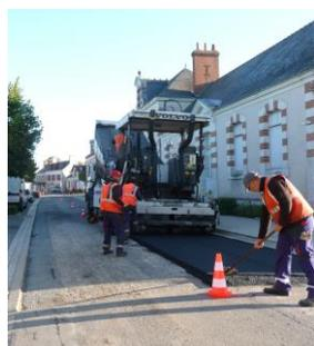
Centre Bourg, du monument aux morts à la boulangerie sur la RD 102, travaux réalisés et pris en charge par le Conseil Départemental. Sur 264 mètres linéaires rabotage de la chaussée (matériaux récupérés pour consolider le Chemin des Boeufs), enrobés à chaud, signalisation horizontale.
