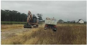
Aux Petites Péraudières. Les travaux ont été effectués par l'entreprise Bessonnier qui a procédé au débernage, rabotage de la partie centrale et curage des fossés. Le but de ces travaux étant de faciliter l'écoulement des eaux pour préserver le chemin de roulement. L'apport de calcaire pour l'entretien sera ainsi diminué, de même que le coût.
