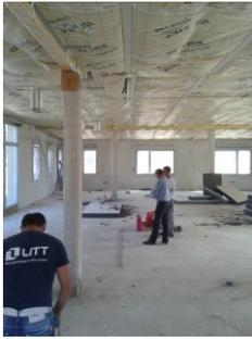
Etat d'avancement des travaux de la Maison de Santé Universitaire. Enduit façade réalisé, cloisonnement et doublage en cours, avec incorporation des lots techniques : électricité et ventilation. Finition de ces travaux prévue fin octobre. Le planning est globalement respecté.
